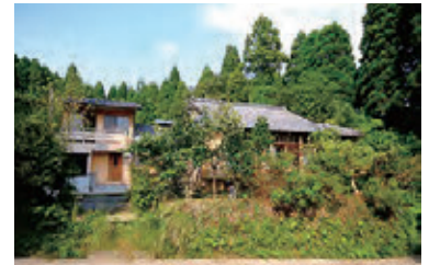
築80年ほどの古民家を改修した施設。ゼネコン時代の経験を活かしてのD.I.Yによる改修は日課の1つ。
